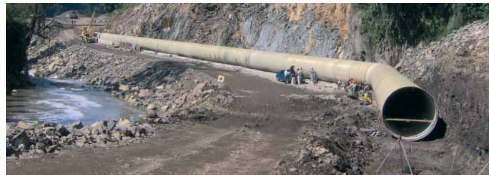
沙特阿拉伯的阿曼特公司能够生产适合高压应用的、具有高强度柔性接头的四米直径管道。
