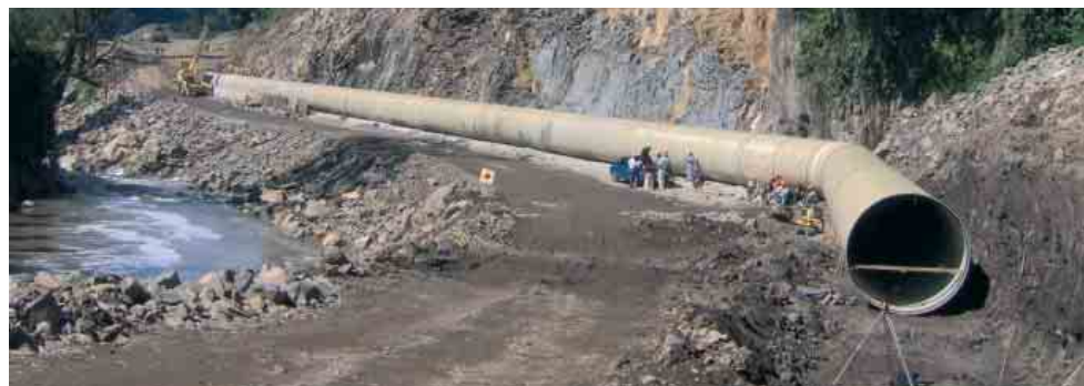
Amiantit (Arabia Saudita) es capaz de producir una tubería de cuatro metros de diámetro con juntas flexibles y altamente sólidas para aplicaciones de alta presión.
