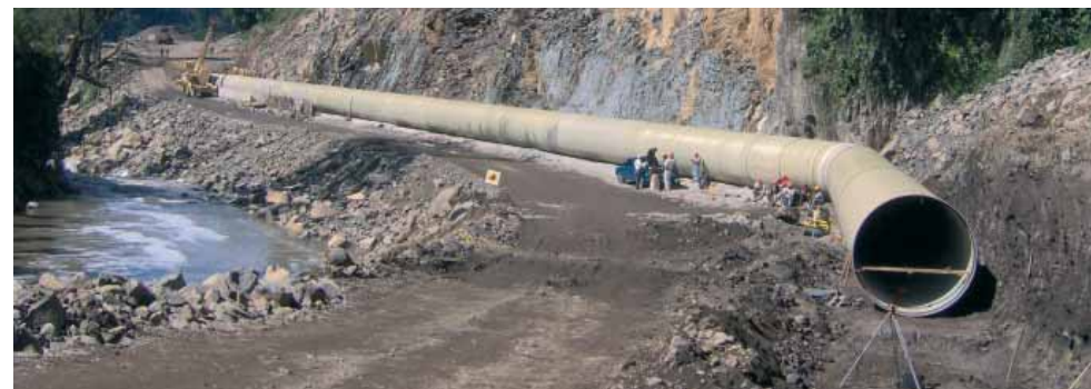
Amiantit(사우디 아라비아)는 고압 적용 분야에 사용될 매우 튼튼하면서 유연한 직경 4m의 조인트용 파이프를 생산하고 있습니다.
